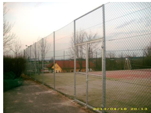
Der durch den heftigen Sturm im Juni 2012 angerichtete Schaden konnte im Frühjahr beseitigt werden. Es war notwendig, den Zaun auf der Westseite neu zu errichten. Der Schaden war größtenteils durch die Versicherung gedeckt
