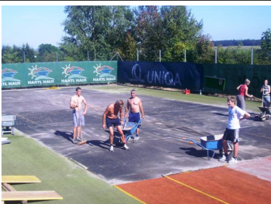
dann wird der Rasen abgetragen ....
